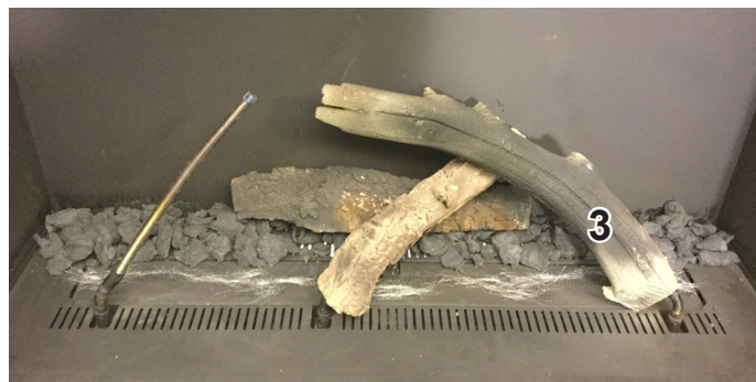
Glisser bloc 3 (avec trou) sur le brûleur flexibles
